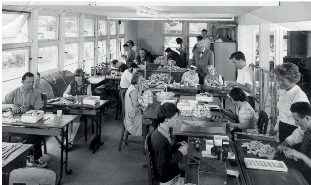
Reparatur und Prüfung von Telefonen der Deutschen Bundespost in der renovierten Bau- baracke des ehemaligen Landesbauamtes.
