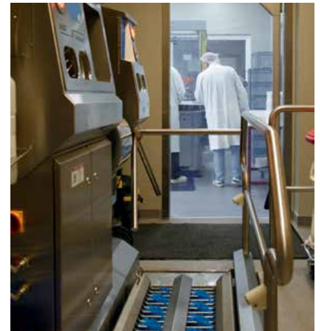
Der einzige Zugang zum Produktionsraum ist die „Schmutzschleuse“
