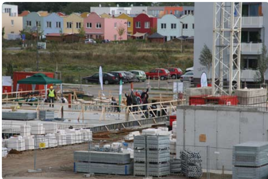
Rohbau Carl-Gauß-Straße 13-15, in der Mitte Marli-Mitarbeiter
