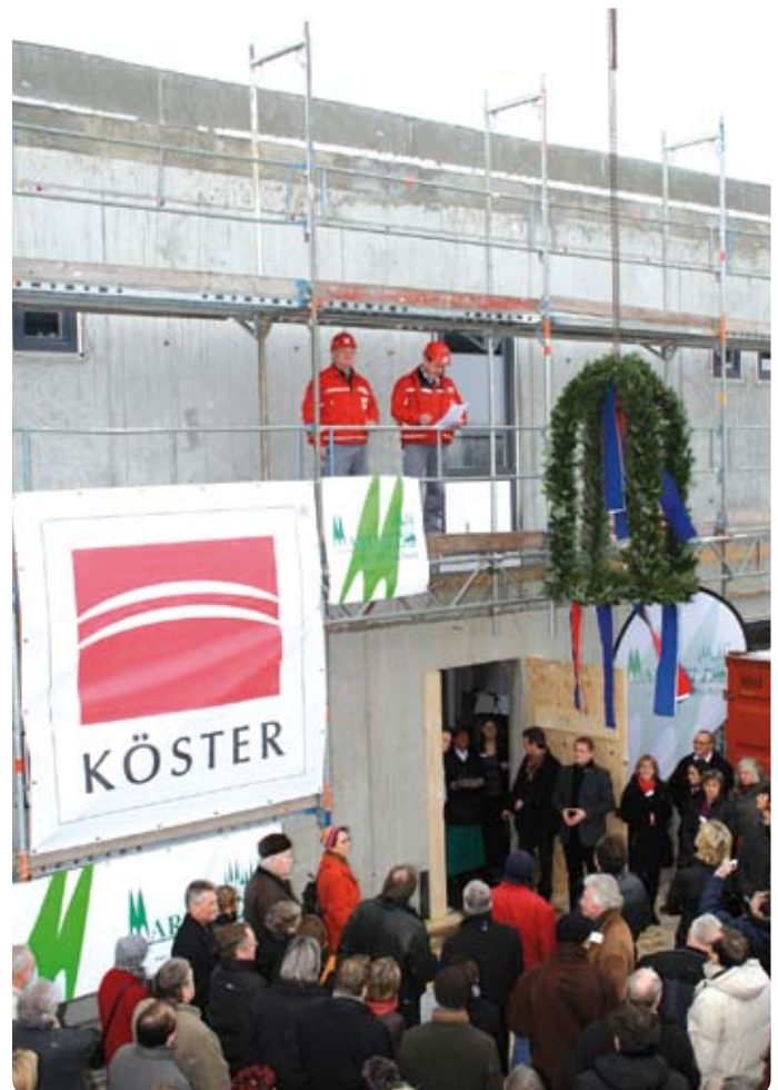
Der Rohbau steht. Im Sommer 2010 soll das Haus bezugsfertig sein
