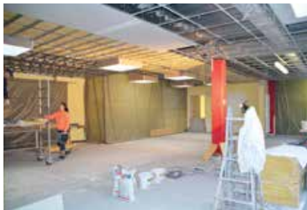
Eine neue Deckenkonstruktion schafft eine bessere Akustik.
