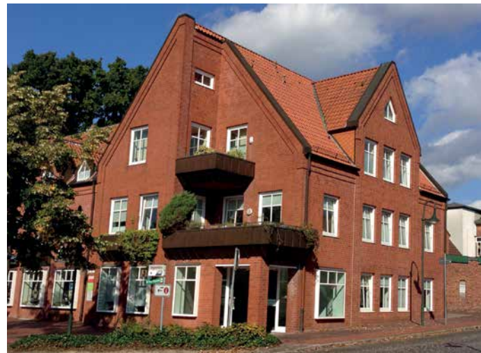
Neue Büros und SeLmA-Treffpunkt in der Freischützstr. 2, Eutin
