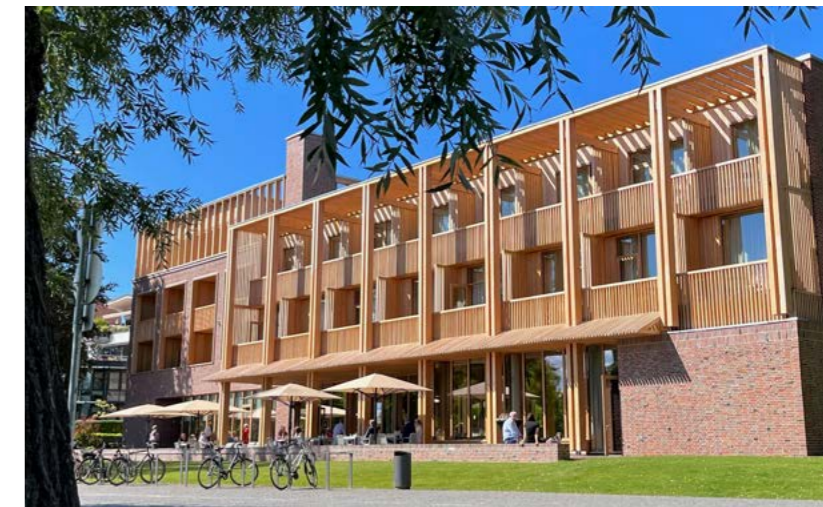
Blick aus Südosten auf die Stein-und-Holz-Fassade
